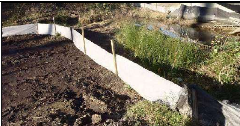
Implantation de barrières amphibiens en géotextile permettant d'éviter les déplacements des individus des fossés vers le chantier © ETEN Environnement
