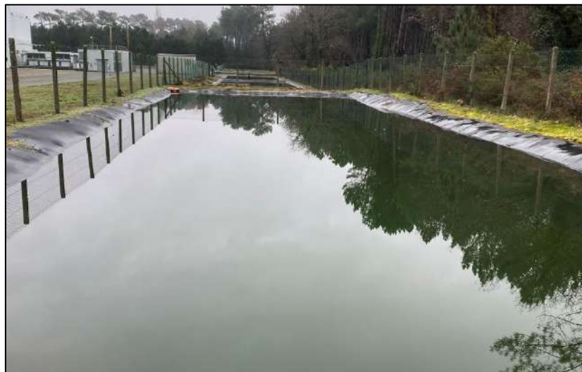
Bassin de rétention ©ETEN Environnement, 26/01/2023
