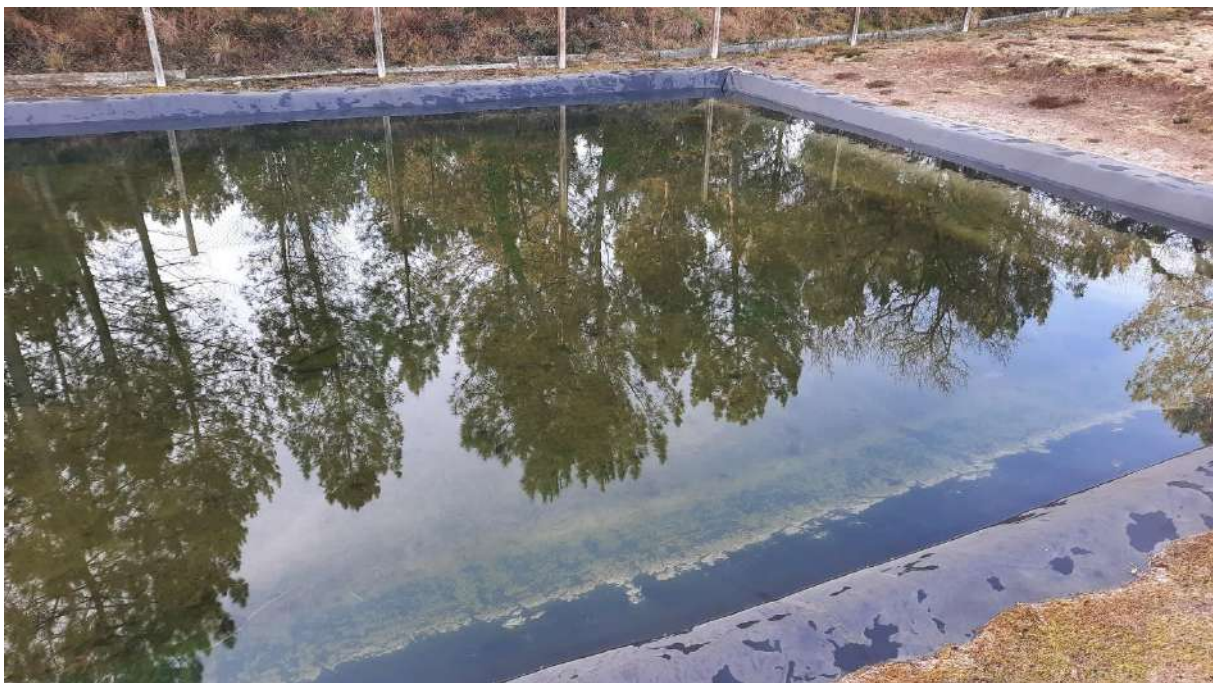
Bassin de rétention d'eau ©ETEN Environnement
