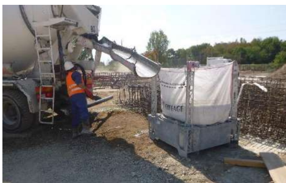
Dispositif de récupération des eaux de nettoyage de toupie béton © ETEN Environnement
