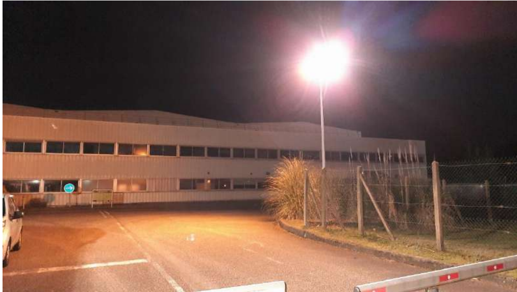
Site éclairé continuellement ©ETEN Environnement
